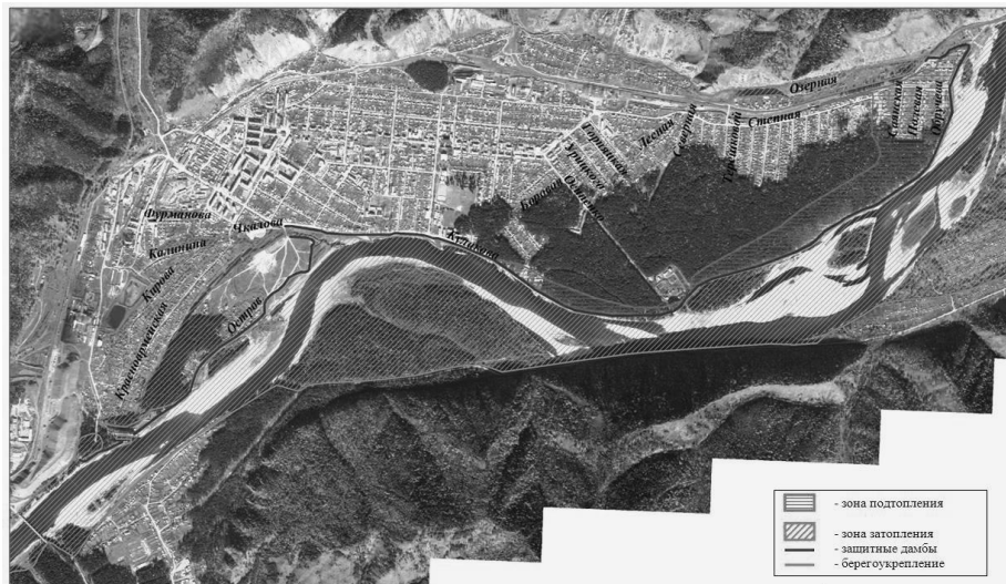
Рис. 2 – Защитные сооружения, зона затопления, зона сильного подтопления в г. Абаза в половодье 2014 г. по результатам обследования
